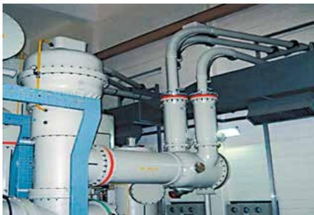
DURESCA 145 kV DG 2000 A. Подключение к КРУЭ 145 кВ
