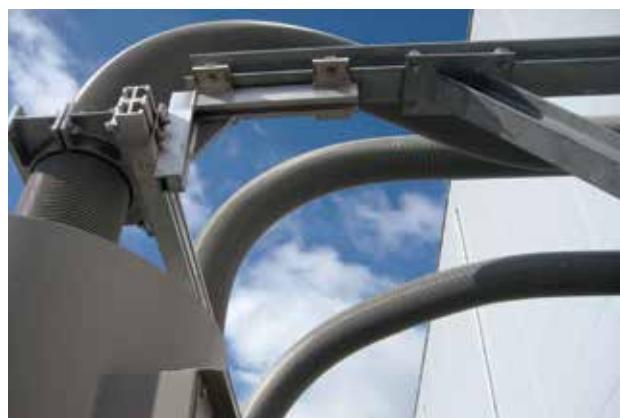
DURESCA 24 кВ 7000 А. Токопровод цепи генератора,
