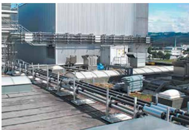
Сдвоенная трасса DURESCA 12 кВ DE 3150 A, DG 4500 A
