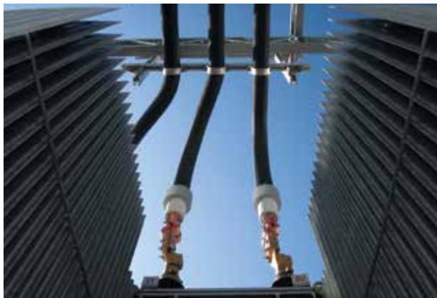
Подключение к трансформатору, наружное исполнение
