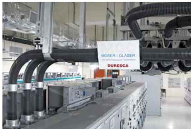
DURESCA 12 kV 2500 A. Подключение к КРУЭ
