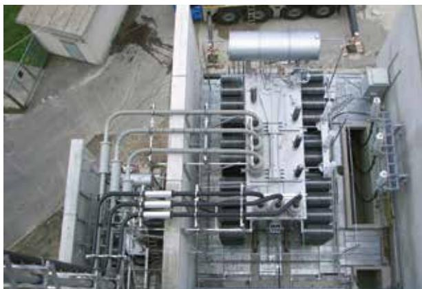
Подключение к трансформатору закрыто защитными боксами
